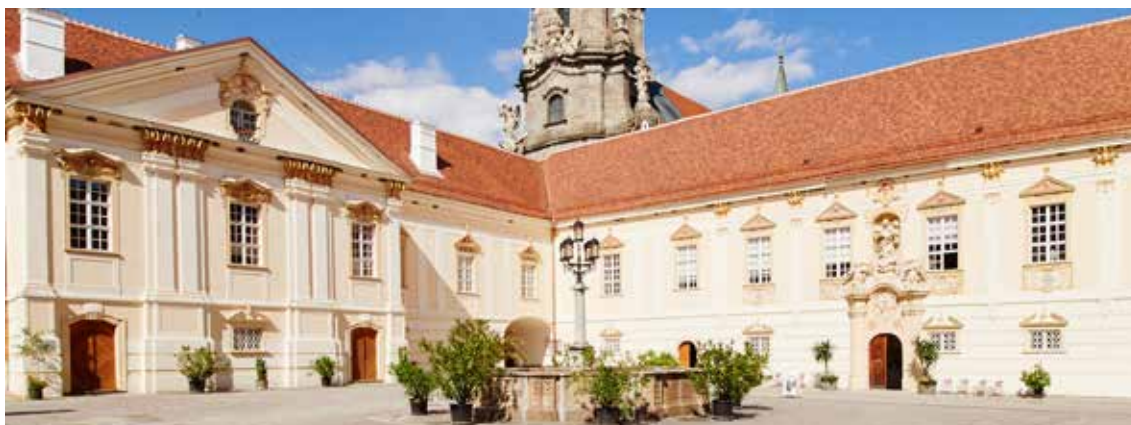
Bei der Gestaltung des Abteihofes ließ sich Baumeister Joseph Munggenast von Fischers Fassade des Palais Trautson inspirieren. Die gedungenen Proportionen und der Verzicht auf reichen Skulpturenschmuck bei den „Risaliten“ (Gebäudevorsprüngen) sind als Geste der Bescheidenheit im klösterlichen Umfeld zu verstehen. (Foto: D. Schewig, schewig-fotodesign)
